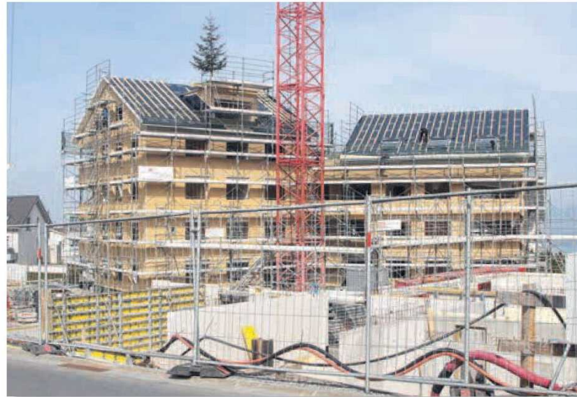
Zwei der insgesamt vier Holz-Wohnhäuser stehen bereits
