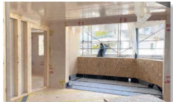
Rohbau: Blick ins Innere einer der 26 Mietwohnungen. Die Decke verfügt über eine UV-beständige Beschichtung, die Wände werden mit Gipsfaserplatten verkleidet.
