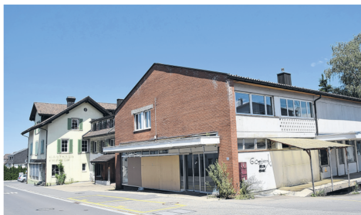
Das Gasthaus Freihof (l.) und der Volg in Schindellegi stehen seit längerem leer, nun können die Gebäude abgerissen werden.
