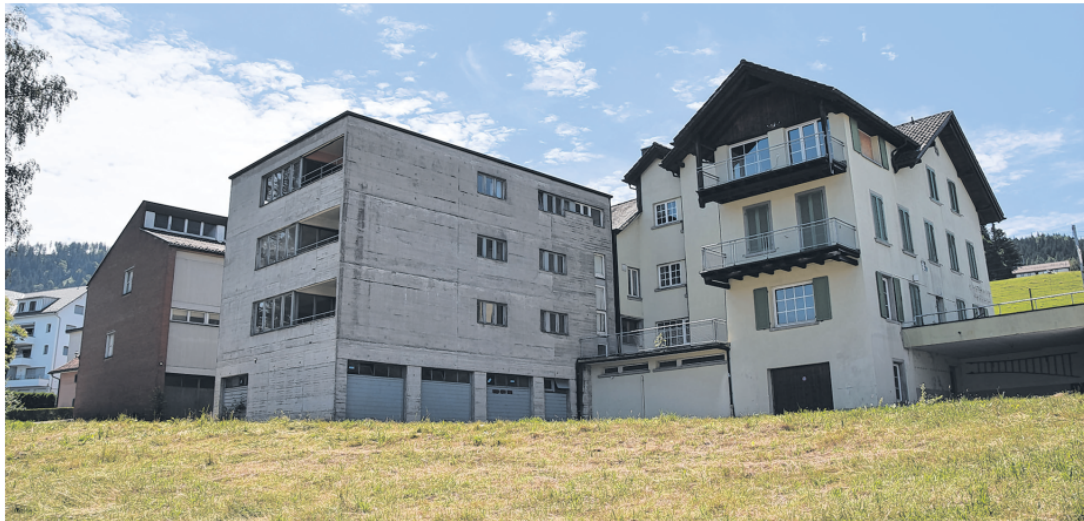
Diese drei Gebäude auf dem Areal Freihofmatte in Schindellegi weichen dem Projekt der Freihof Immo AG. Baustart ist voraussichtlich diesen Herbst.
